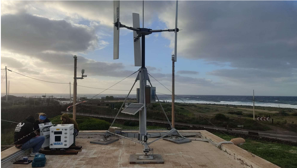
Figura 3.2-5: Vaisala WindCube® (Modello WCL21) installato a Pantelleria.
